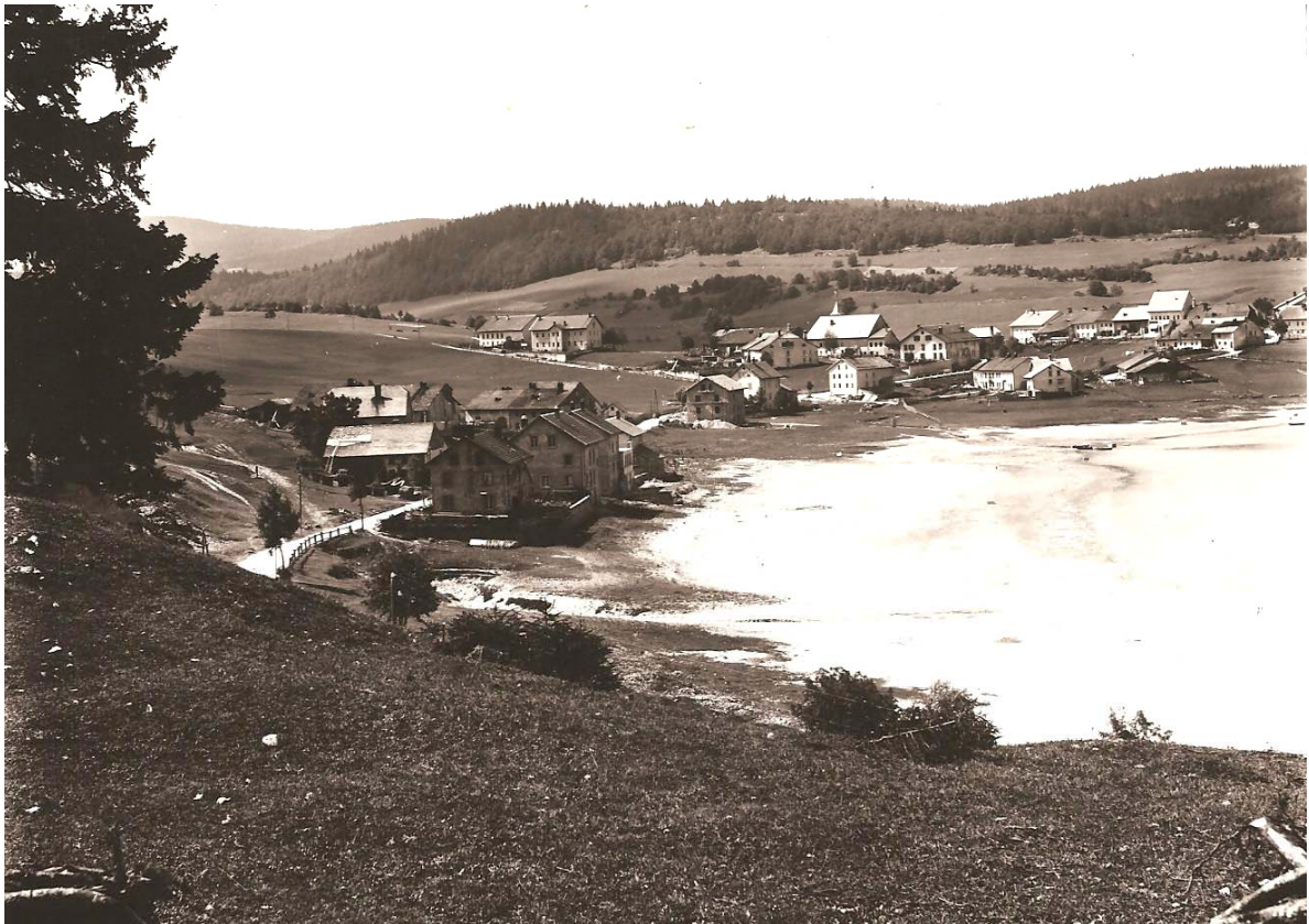
Le quartier des Crettets, aux Charbonnières, alors en pleine construction, avec pour l'essentiel des bâtiments la présence de l'entrepreneur Fantoli, désormais installé dans la place.
